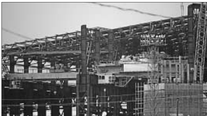
Строительство нового прокатного стана, 2007 год
